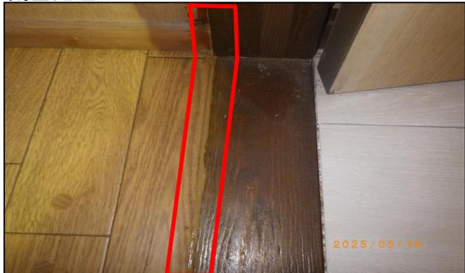
リビングサッシ枠下端:喰害発生箇所
