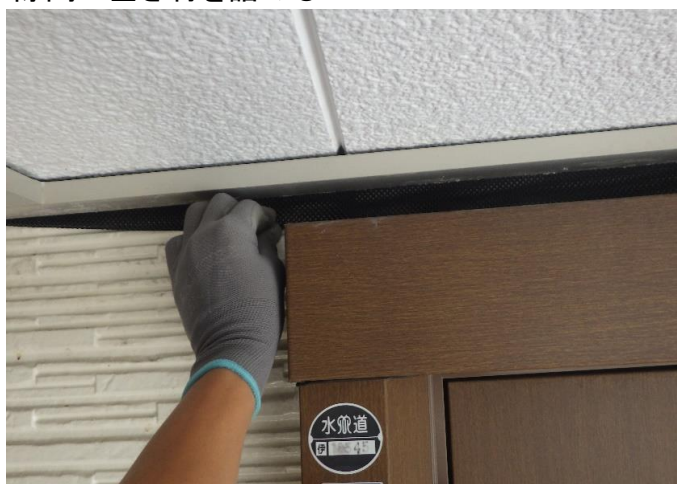
隙間に塞ぎ材を詰める
