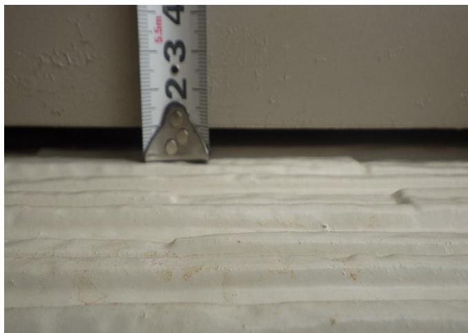
玄関先: 壁面とポーチ天井部の隙間
