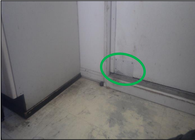
金属板にて閉塞処理
