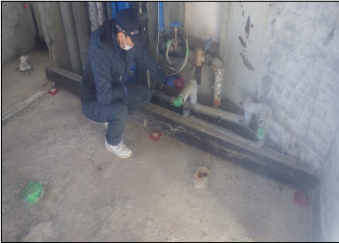
殺鼠剤再設置及び増設
