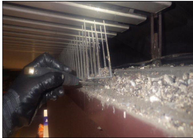
[redacted]: 防鳥スパイク設置 旧資材剥離及び回収
