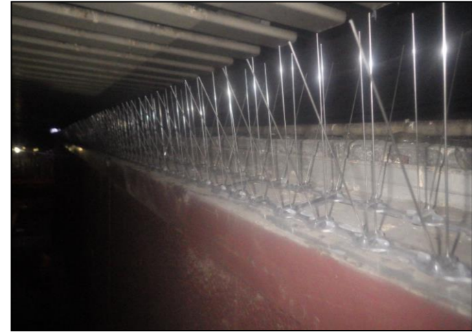
防鳥スパイク設置完了
