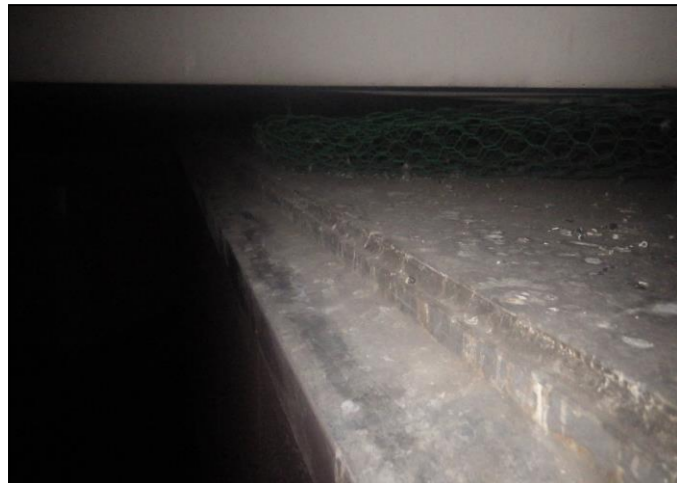
資材回収及び清掃後
