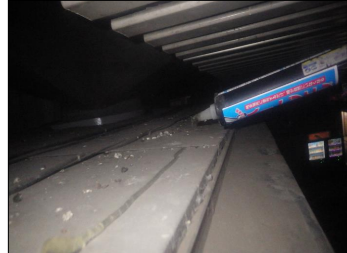
店舗正面: 防鳥スパイク設置 鳩専用忌避剤塗布処理
