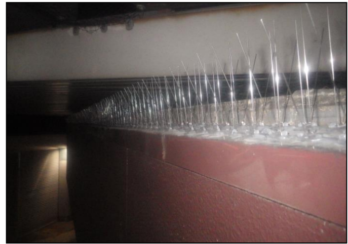
防鳥スパイク設置完了
