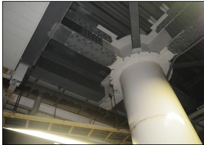
柱上部H鋼: ネット取付後 14
