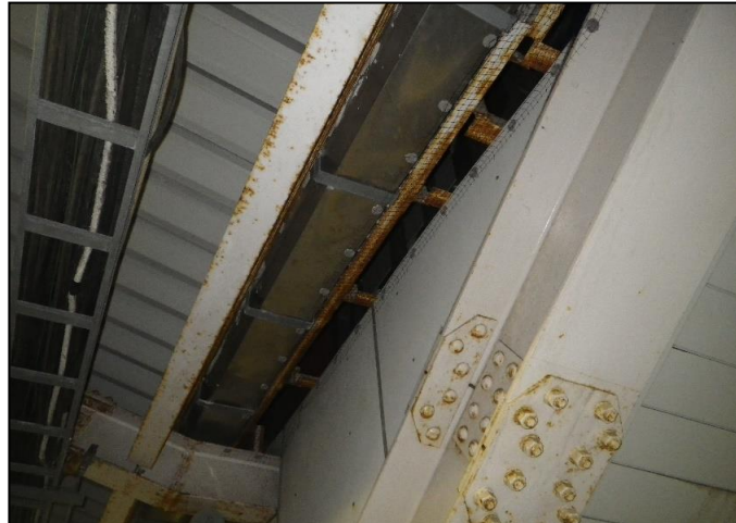
雨樋隙間: ネット取付後 16
