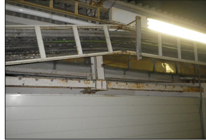
雨樋隙間: ネット取付後 18
