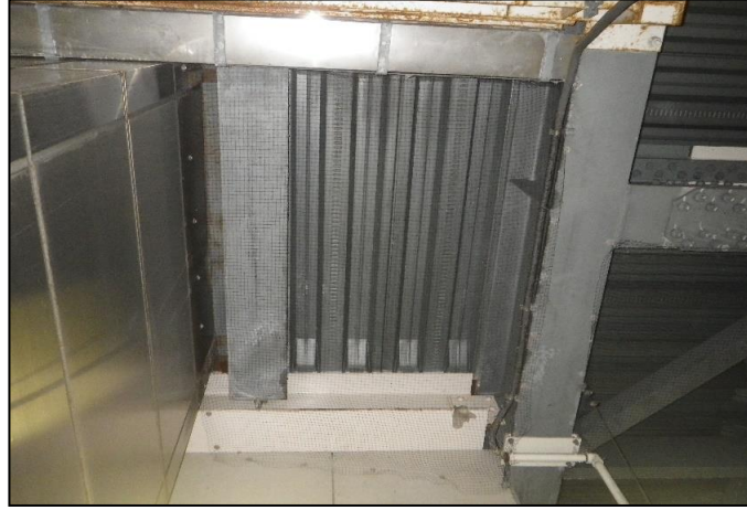
柱上部H鋼: ネット取付後 12
