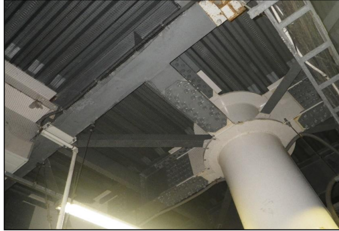
柱上部H鋼: ネット取付後 13
