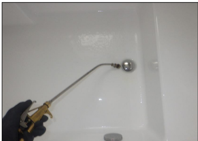
2F浴室浴槽排水口: 液剤噴霧 2
