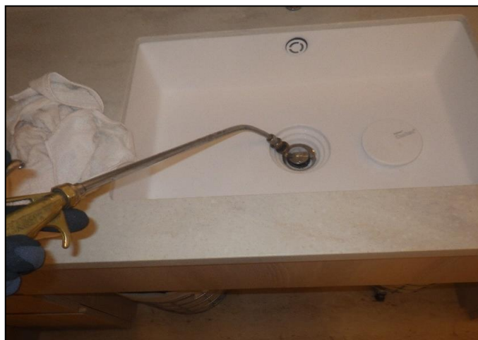
2F洗面台排水口: 液剤噴霧 5
