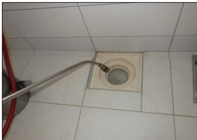
2F浴室排水口: 液剤噴霧 3
