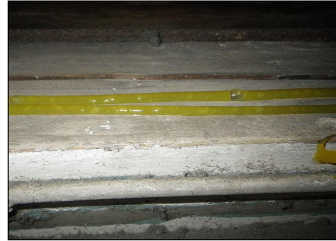
階段: 忌避剤塗布後
