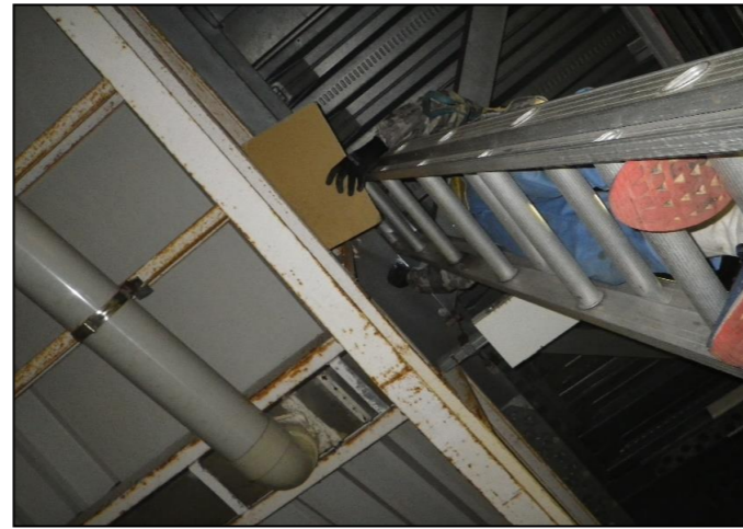
柱上部H鋼: ネット下地取付
