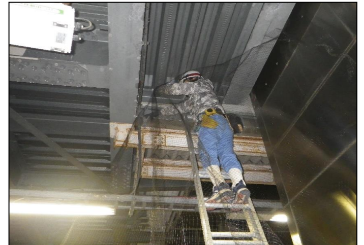
柱上部H鋼: ネット取付
