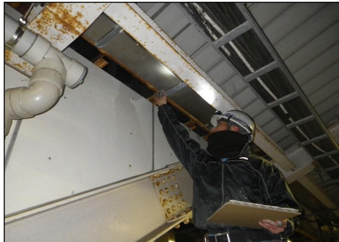
雨樋隙間: ネット下地取付
